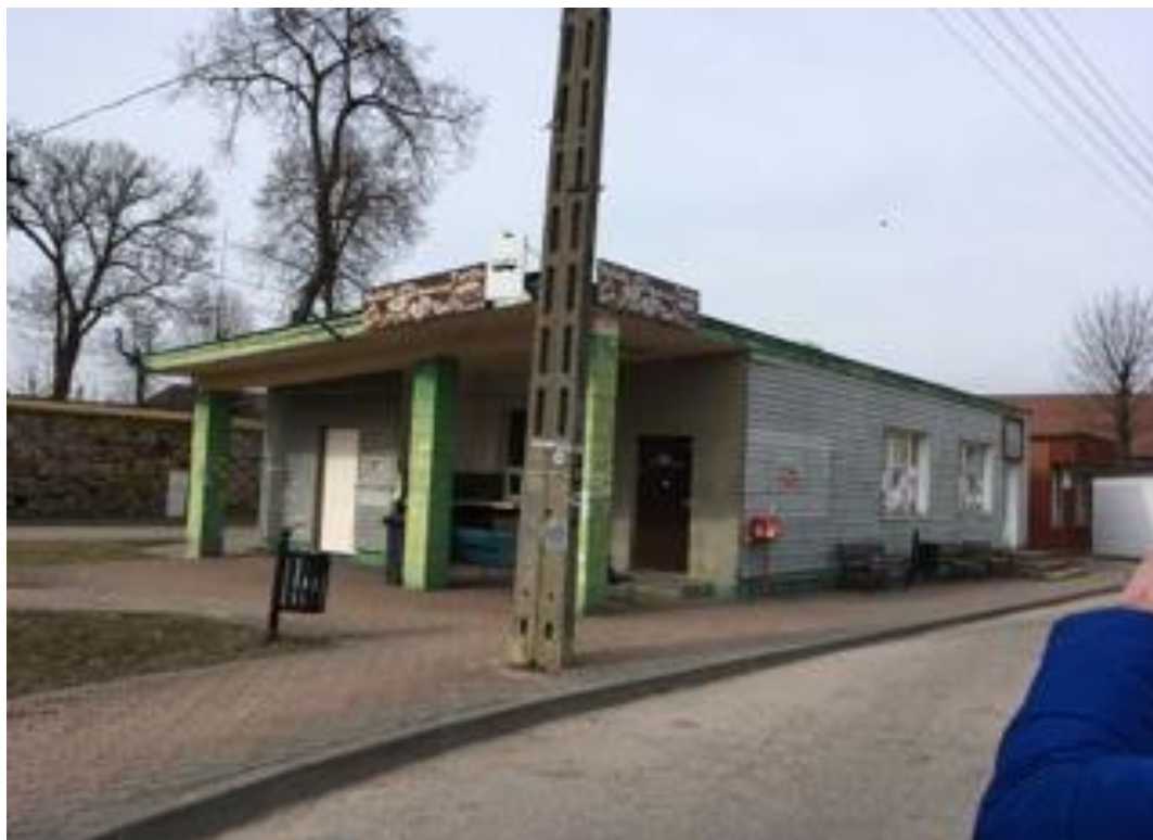
Fotografia 1. Budynek dworca PKS w Centrum Suchowoli
