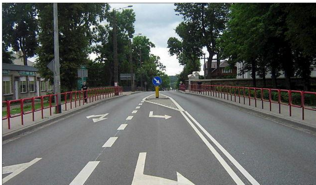
Fotografia 2. Droga krajowa S-8 przebiegająca przez Centrum Miasta Suchowola
