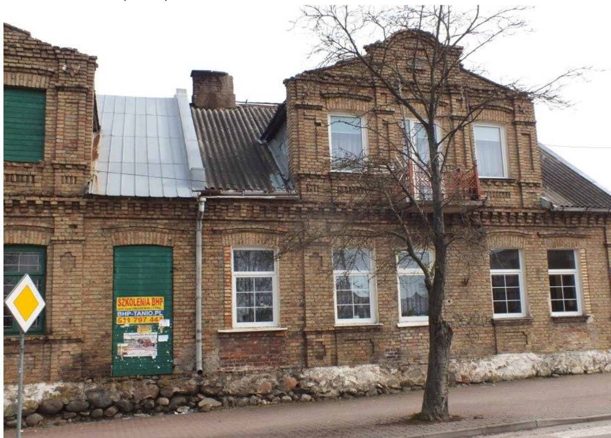
Fotografia 3. Kamienica w Centrum Suchowoli
